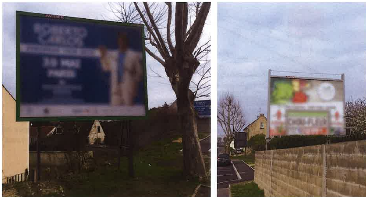
Publicités et préenseigne scellées au sol ne respectant ni les règles de surface maximale ni celles d'implantation par rapport aux limites séparatives
